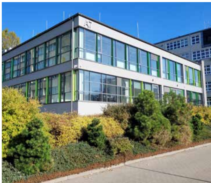
Wyremontowany budynek A7 foto: Jacek Szabela
