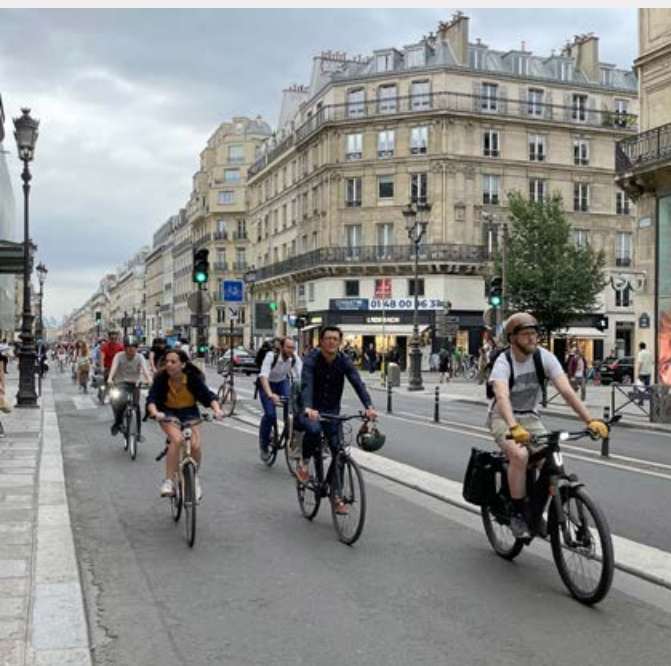
Rue de Rivoli w Paryżu po przebudowie, z dwoma szerokimi pasami dla ruchu rowerowego i jednym wąskim dla pojazdów zmotoryzowanych, fot. Małgorzata Hanzl
